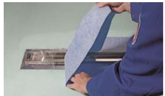
Aufkleben der Dichtmanschette
