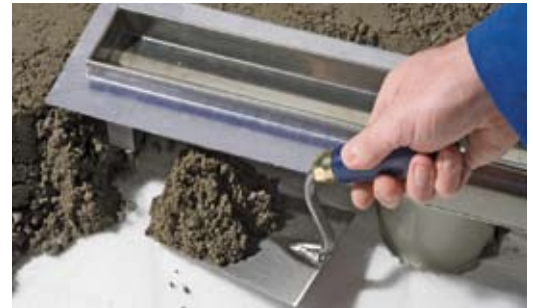
Einbau der Duschrinne und Verfüllen mit Estrich
