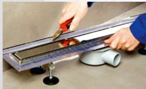
Abwinkeln des Duschrinnenflansches vor dem Einbau.
