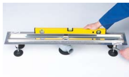
Ausrichten der Höhe mit der Wasserwaage
