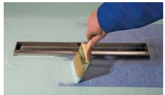
Aufbringen des Isolieranstrichs
