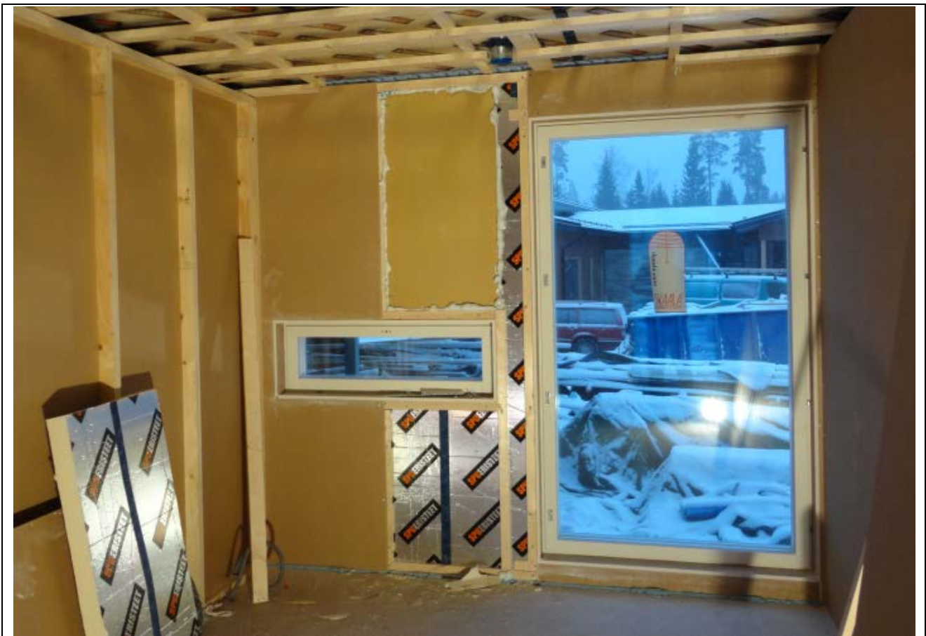
Kuva 3.3. SPU R-eristelevy pilottikohteen seinässä (vasemman puoleisen ikkunan yläpuolella).
