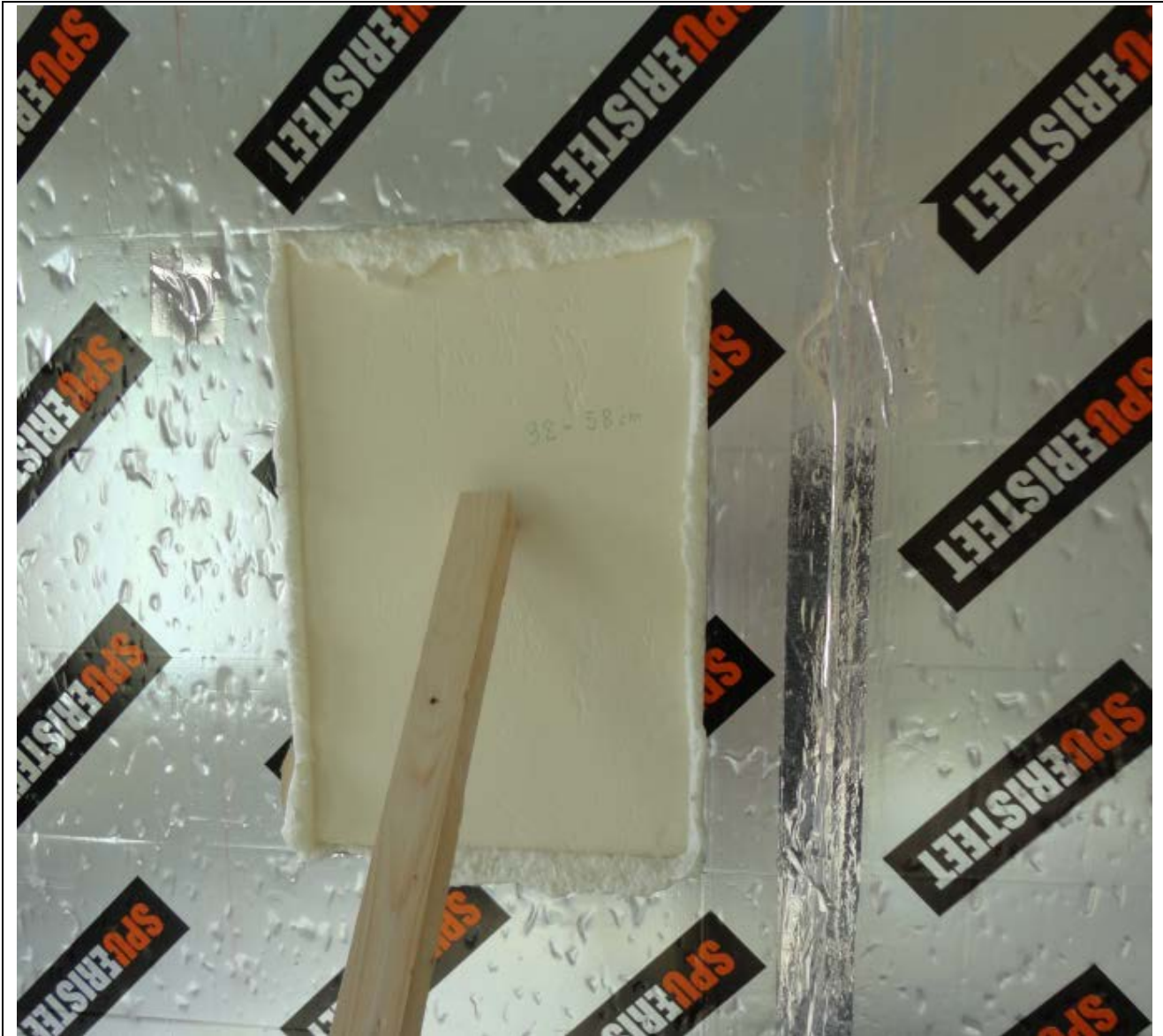
Kuva 4.3. Kuorittu SPU AL eristelevy pilottikohteen seinässä.
